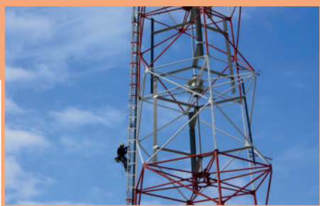
WIND'IT – PYLÔNE ÉOLIEN RELAI DE TÉLÉCOMMUNICATIONS
