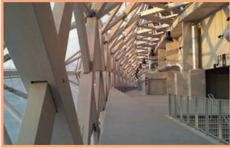
STADE ALLIANZ RIVIERA – STRUCTURE MIXTE BOIS-ACIER ET COUVERTURE EN TOILE
