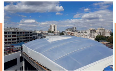
IMMEUBLE BULL GAMBETTA – RÉNOVATION DE LA COUVERTURE DE L'ATRIUM
