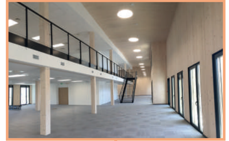
PALAZZO NICE MÉRIDIA – BÂTIMENT BOIS DE GRANDE HAUTEUR
